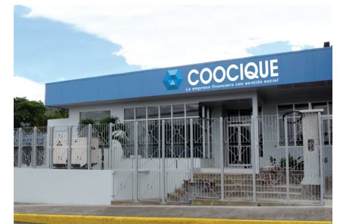
Edificio Tecnología de Información, Oficinas Centrales
